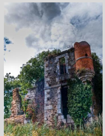
Ruines du château de la Lière
